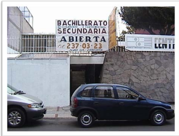
Foto: fachada del CEA en la 21 poniente N. 110 – Antigua ubicación.
